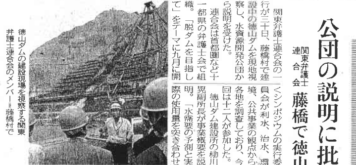
徳山ダムの建設現場を視察する関東弁護士連合会 井護士連合会のメンバー藤橋村で
