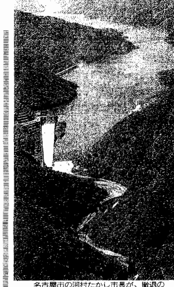
名古屋市の河村たかし市長が、撤退の方針を示した木曾川水系導水路事業の現場。徳山ダムで水を送る徳山ダム＝14日、岐阜県揖斐郡川口町で、本社へ「あざさる」から
